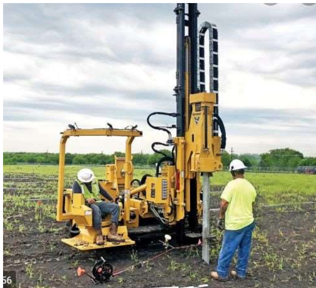
Figur 3. Pålning av stålprofiler.
