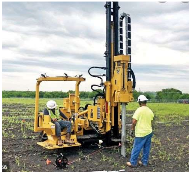
Figur 3. Pållning av stålprofiler. Källa: LC Energi
