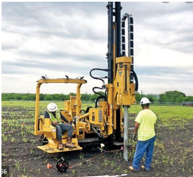
Figur 3. Pålning av stålprofiler. Källa: LC Energi.
