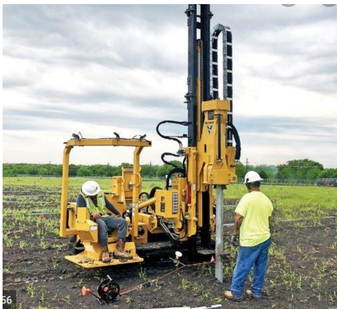
Figur 3. Pållning av stålprofiler (LC Energi, 2023)
