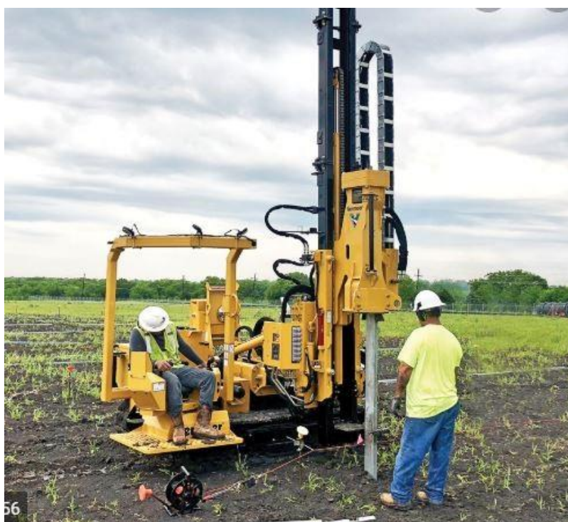
Figur 7. Pålning av stålprofiler (LC Energi, Platsbesök solpark Holland, 2023)
