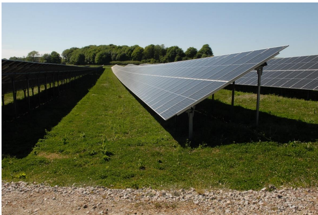
Figur 5. Solceller på stativ med fast lutning (LC Energi).
