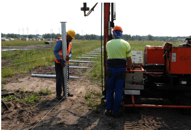
Figur 8. Markskruvmaskin (LC Energi, Platsbesök solpark Holland, 2023).
