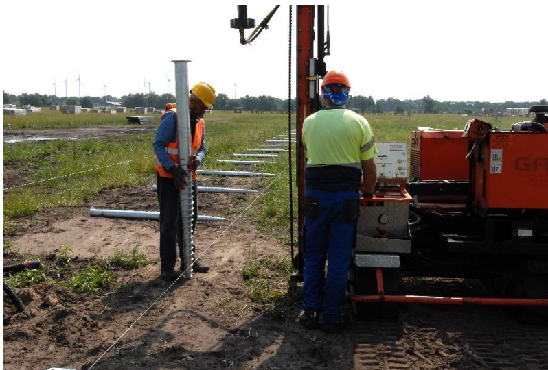
Figur 8. Markskruvmaskin (LC Energi, Platsbesök solpark Holland, 2023).
