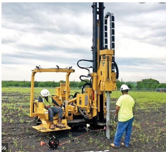
Figur 3. Pålning av stålprofiler. Källa: LC Energi
