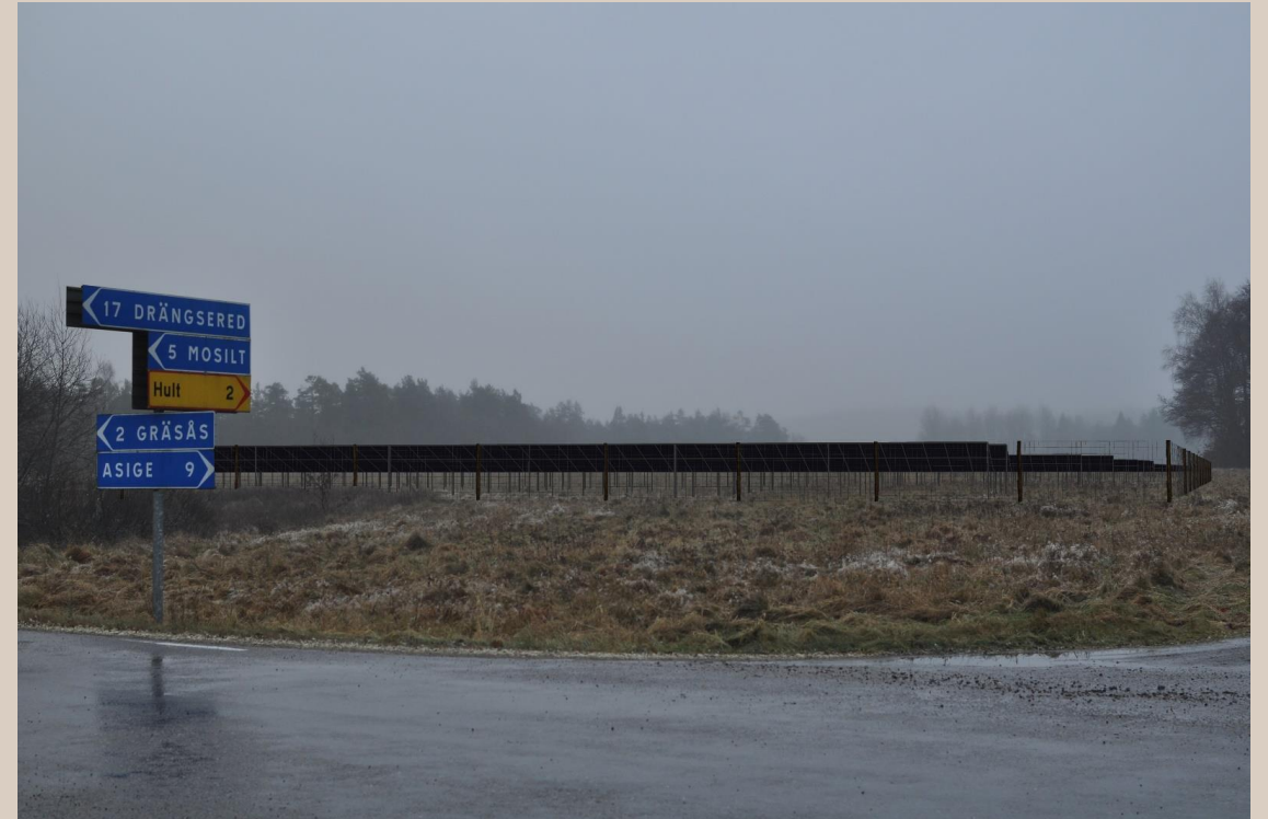
Solpark som omgärdas av staket
