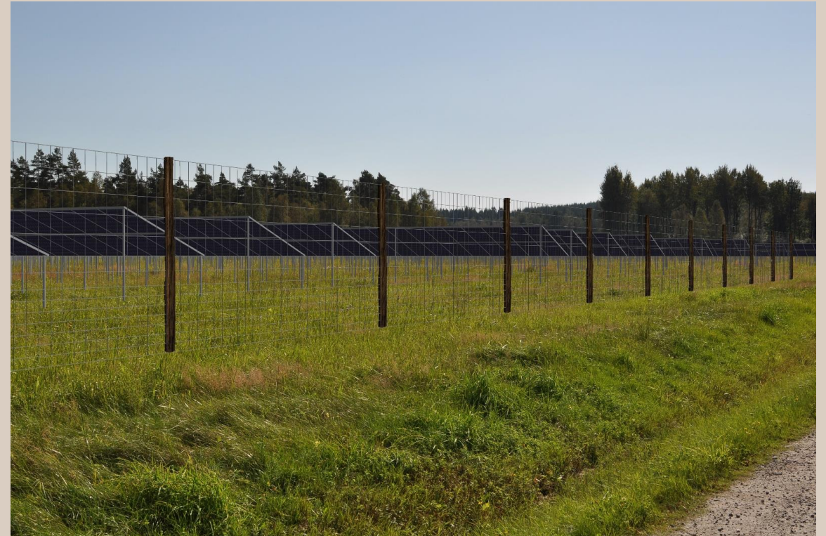
Solpark som omgärdas av staket
