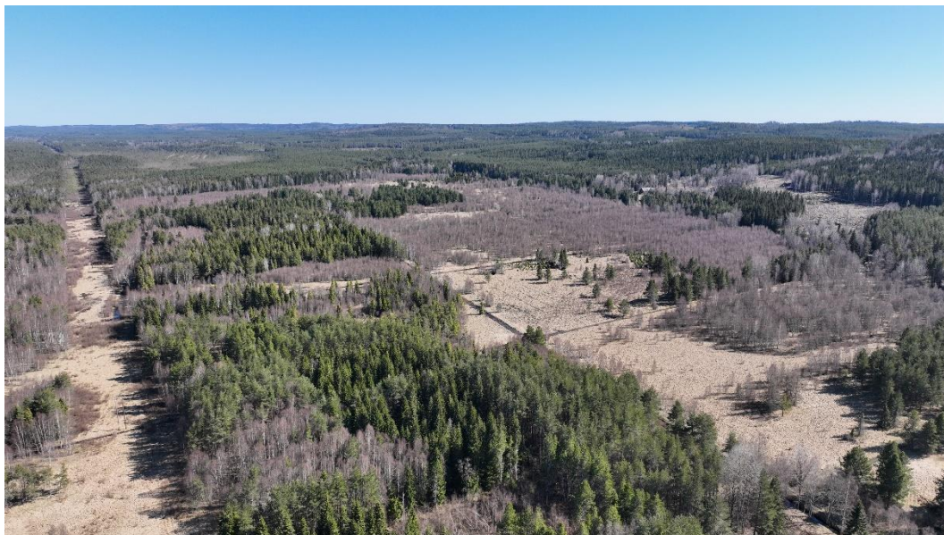
Figur 22. Drönerfoto över verksamhetsområdets västra del. Fotot är taget västerifrån, i östlig riktning. (LC Energi, 2023)
