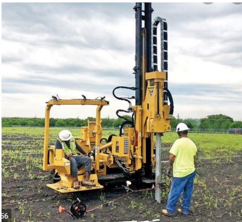
Figur 3. Pålning av stålprofiler. Källa: LC Energi.
