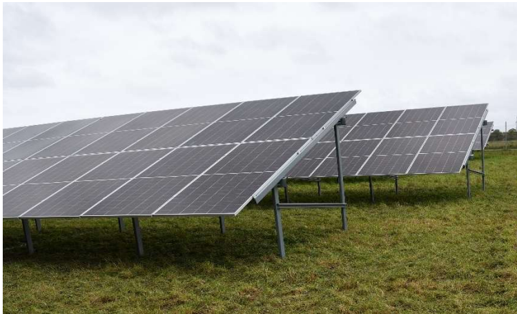
Figur 3. Exempel fasta paneler (LC Energi, 2023)
