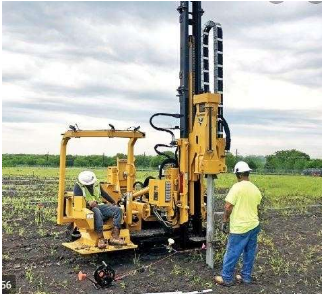
Figur 2 Pålning av stålprofiler (LC Energi, 2023)
