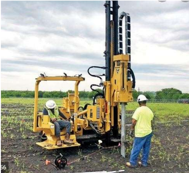
Figur 2 Påning av stålprofiler. Källa: LC Energi
